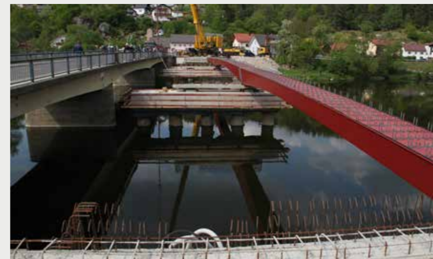
Herstellung des neuen Überbaus in Behelfslage
