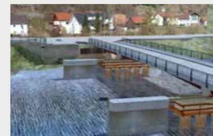
Neuer Überbau in Behelfslage fertiggestellt, Bestandsüberbau bereits rückgebaut
