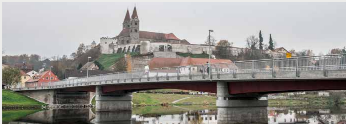
Brückenansicht nach der Überbauerneuerung
