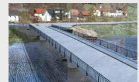
Neuer Überbau in Endlage, Rückbau der Behelfsunterbauten in Vorbereitung
