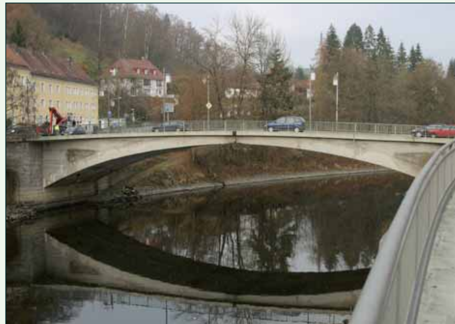
Bestandsbauwerk, Blick von unterstrom
