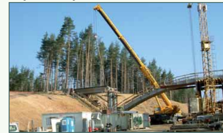
Montage der Fahrbahnfertigteile
