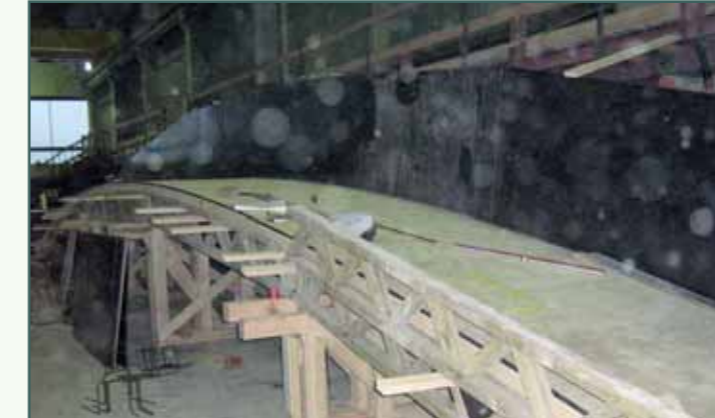
Montage der Fahrbahnfertigteile
