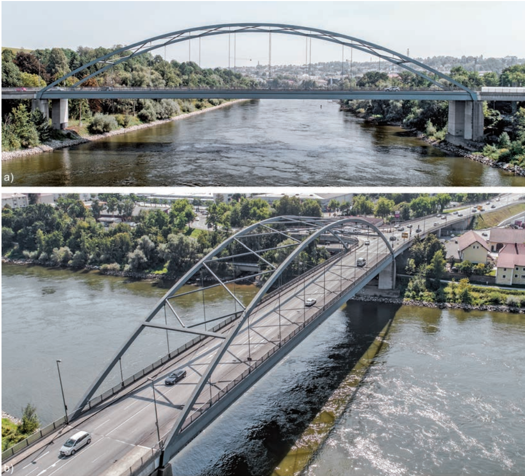
Bild 1 a) Ansicht und b) Draufsicht der Franz-Josef-Strauß-Brücke in Passau a) Front and b) top view of the Franz-Josef-Strauß-Bridge in Passau
